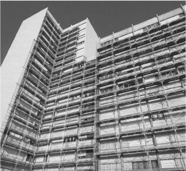
Figure 3 – Échafaudage de façade
