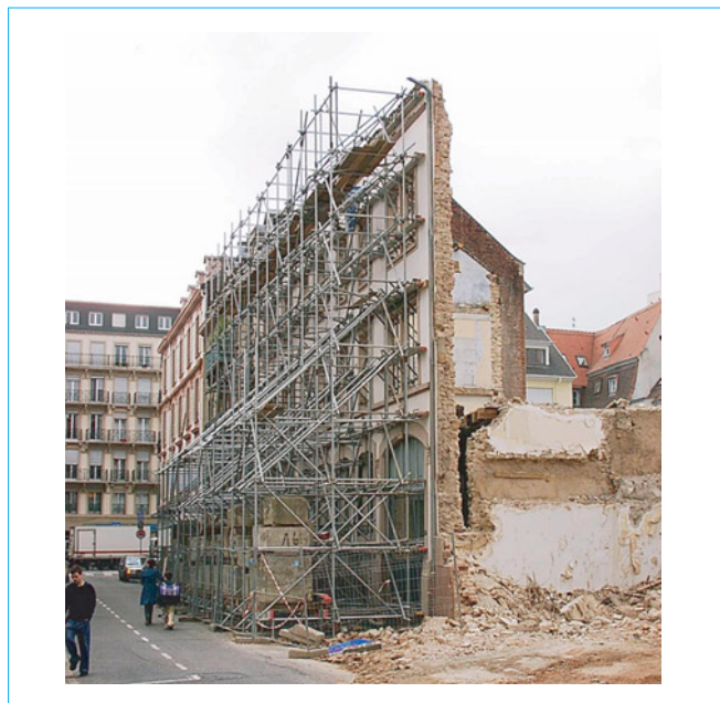
Figure 6 – Étançonnement de façade
